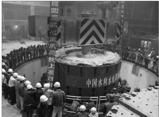
図 10 1号機の回転子つり込み
