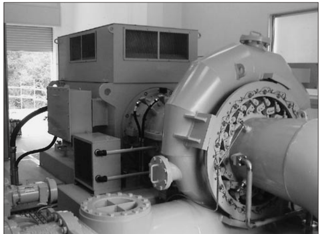
図 11 営業運転中の水車・発電機
