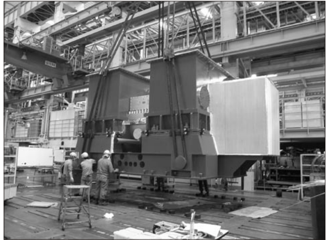
図4 富士電機・川崎工場でのタービン組立風景
