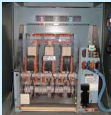
既設品コンタクト 19** 年製 HC23 気中電磁接触器
