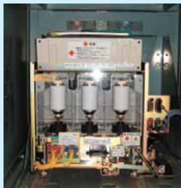
置換えコンタクト 2012 年製 HN46AX-2S-HC 真空式電磁接触器
