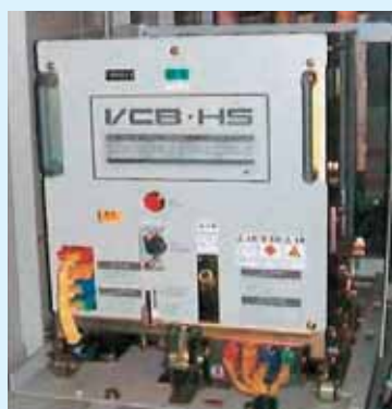
置換え VCB 2011 年製 HS2006X-06Mf-EVNZ
