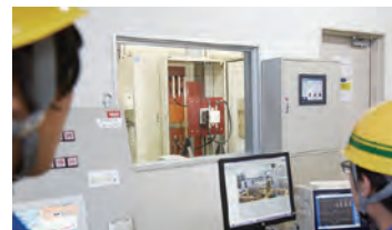
事故を想定した大電流を通電し、安全性を検証する遮断試験
