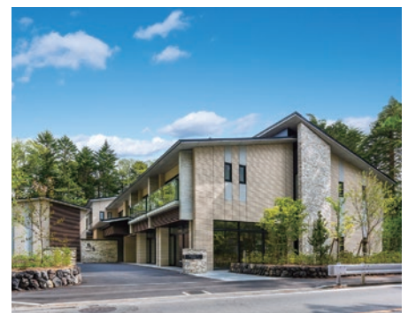
株式会社熊谷組 軽井沢研究所 内線電気工事
