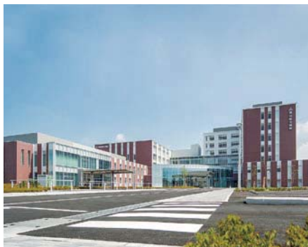
医療法人熊谷総合病院 空調設備工事
