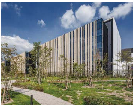
中外製薬株式会社 中外ライフサイエンスパーク横浜 空調設備工事
