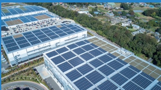
※自家消費型太陽光発電設備
