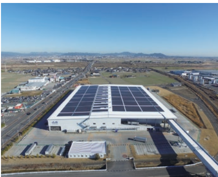
アサヒ飲料株式会社 群馬工場 自家消費型太陽光発電設備工事
