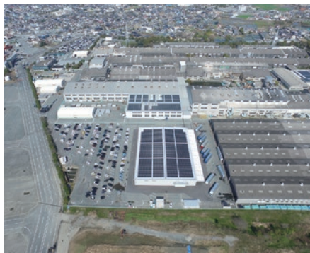
不二ライトメタル株式会社 本社工場 自家消費型太陽光発電設備工事
