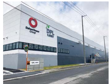
大和ハウス工業株式会社 DPL札幌南IV 新築工事 機械設備工事
