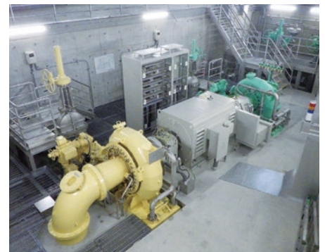
独立行政法人水資源機構 川上ダム 水力発電設備工事
