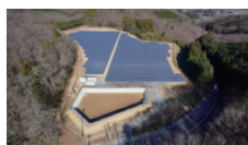
那須烏山太陽光発電所
