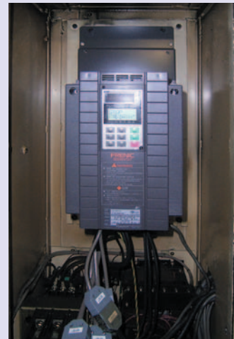
新ユニット (置換え後)
