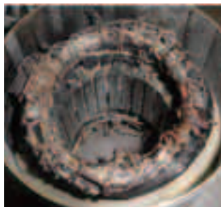
コイル部の焼損 Coil burnout
