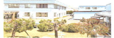
技能研修センター
