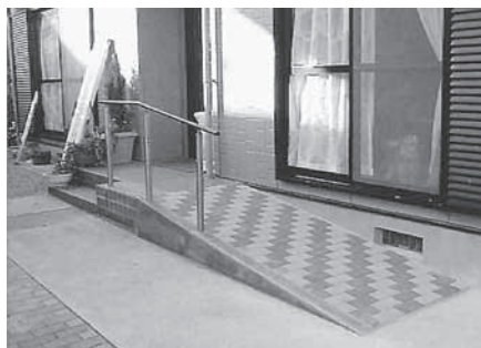
工事例 1：屋外手すりとスロープの設置
