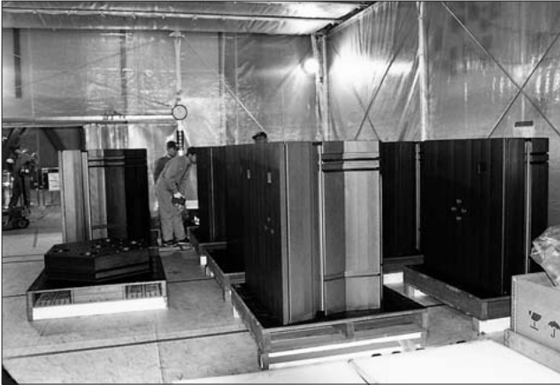
図9 炉内構造物のクリーンハウス内での保管
