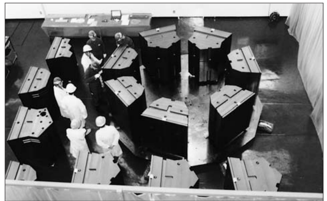
図3 炉内構造物の検査場所での検査状況
