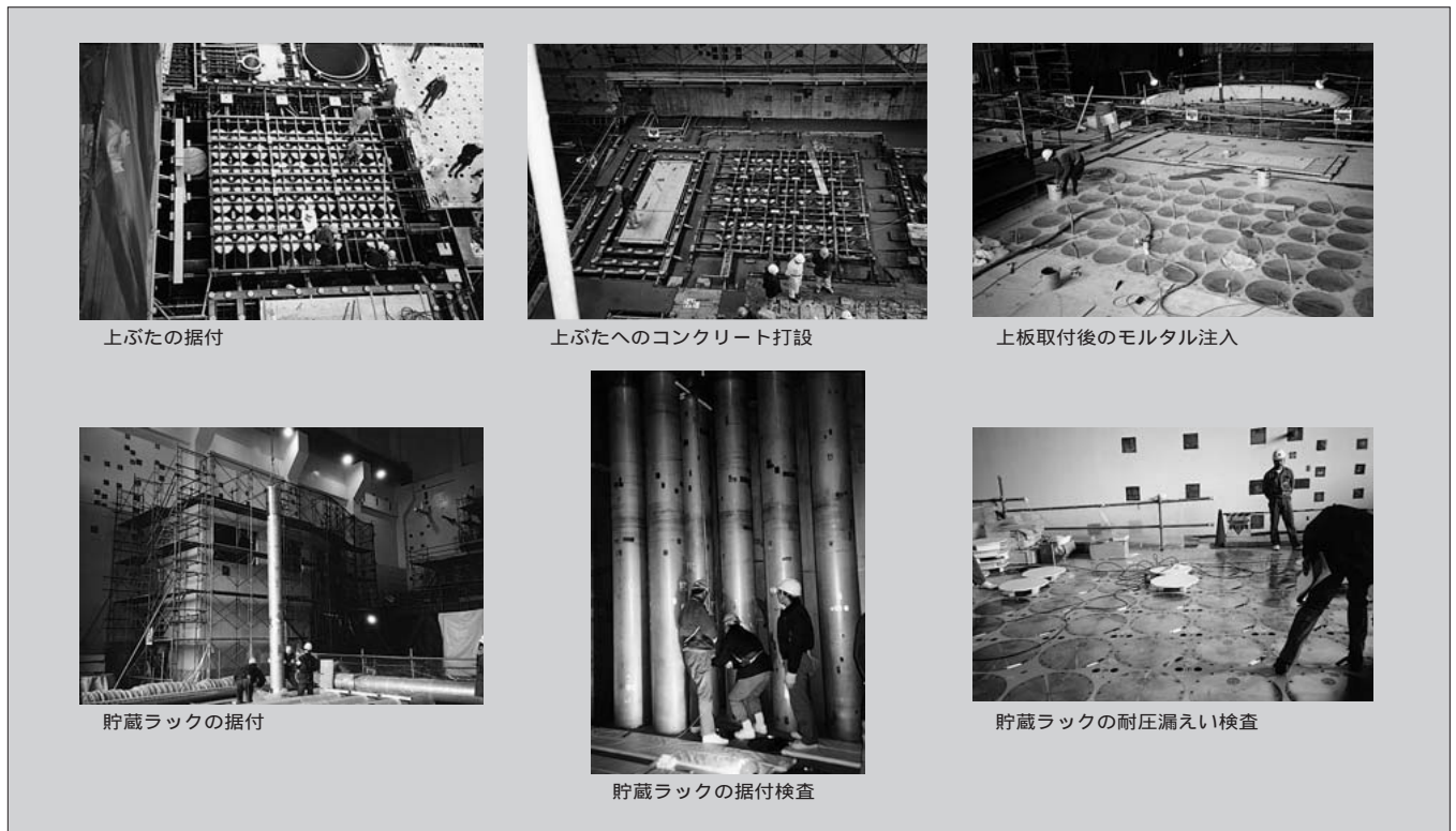
図3 貯蔵プール設備の据付
