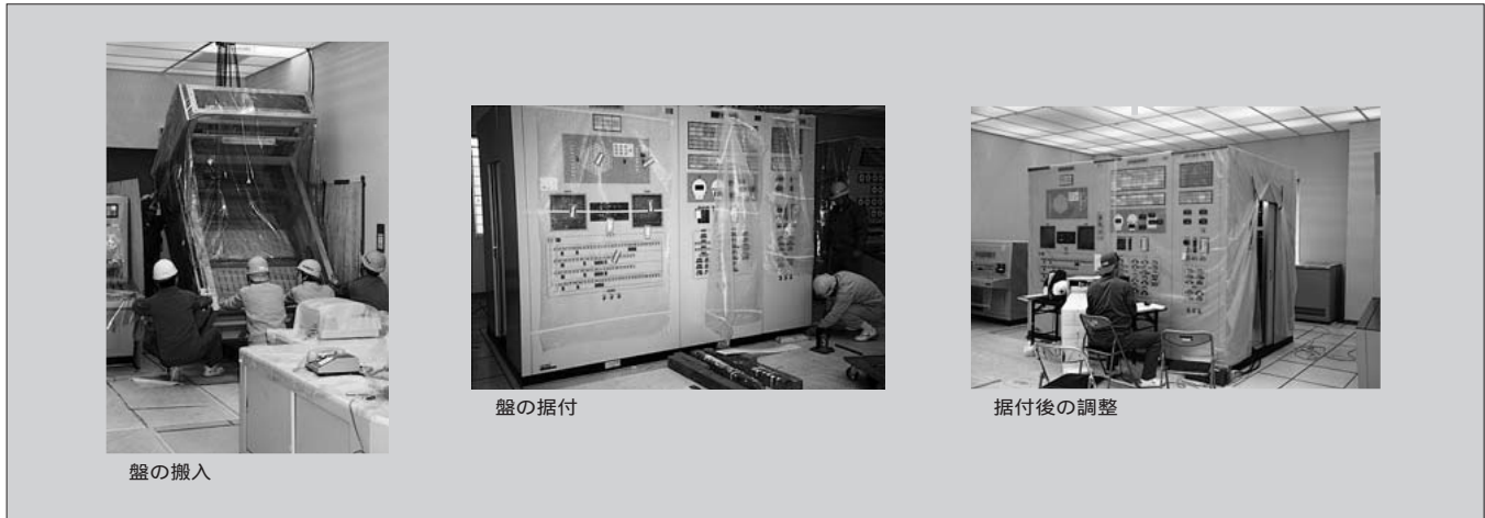
図4 燃料取扱及び貯蔵設備計装制御設備の据付
