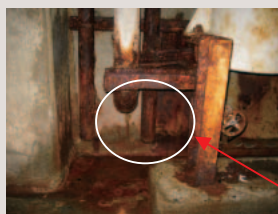
タービン軸受廻りドレン配管 ドレン排出部
