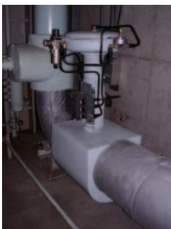
⑤ 低圧給水加熱器 ドレン制御弁
