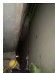
高所部位噴霧 (延長棒使用)
