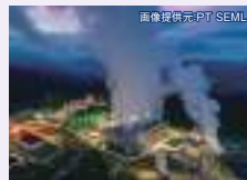
地熱発電設備
