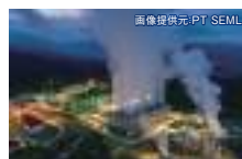
Muara Laboh Geothermal Power Plant (インドネシア)
