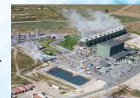
■地熱発電設備
